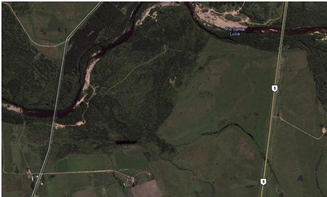
Figura 6. Vista general del bosque ribereño en el área de estudio. Puentes de la Ruta Nac. N° 5 vieja (izquierda) y nueva (derecha).
