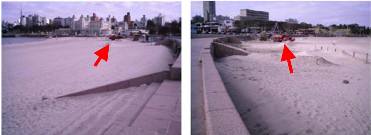
Figura 13. Remoción con retroexcavadora y camión (flecha) de la arena transportada por el viento a la playa supramareal antes del inicio de la temporada veraniega. La arena devuelta a la línea de costa.
