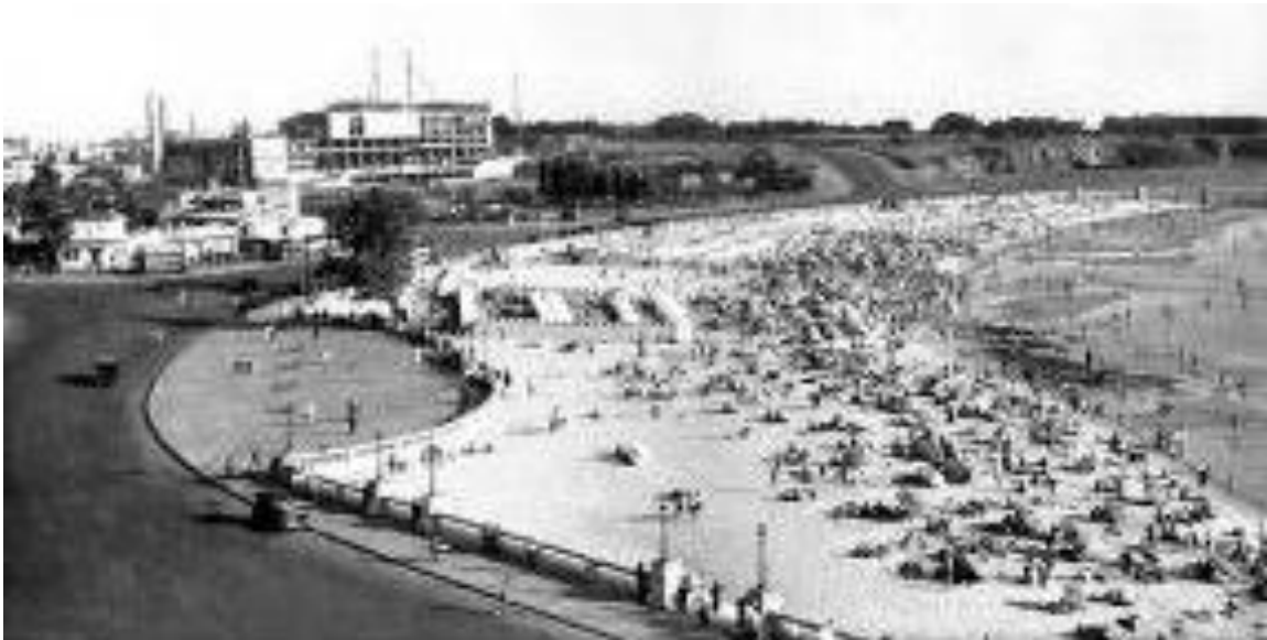
Figura 4. En la foto del año 1940, se puede apreciar la ubicación del descanso existente para la época en Playa Ramírez. Para el año 1945 (próximo registro fotográfico disponible) este ya había sido retirado. Foto: CMDF-IMM (Centro Municipal de Fotografía, Intendencia Municipal de Montevideo).
