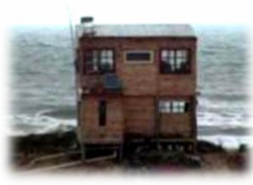
Fig. 58. Vista posterior de construcción parador y hostería sobre el cordón dunar de la “primer cañada” en el arco de la playa de la Ensenada (2010)
