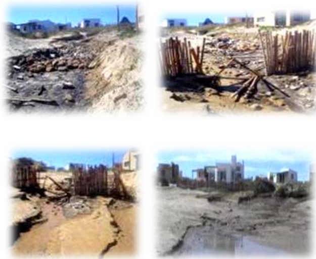
Fig. 124. Erosión en la playa de la Ensenada (2006).
