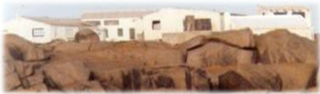
Fig. 10. Construcciones en el frente rocoso del promontorio sector sur oeste (2005)
