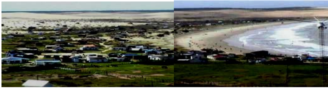
Fig. 66. Vista parcial de la cabecera de la playa de la Calavera y tómbolo sector noreste, con unidades constructivas. (2010)
