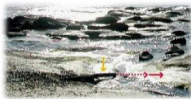
Fig. 105. Desagüe de aguas servidas sin tratamiento, con vertido directo al océano en la zona del Poblado, zona de Hostales (2008)
