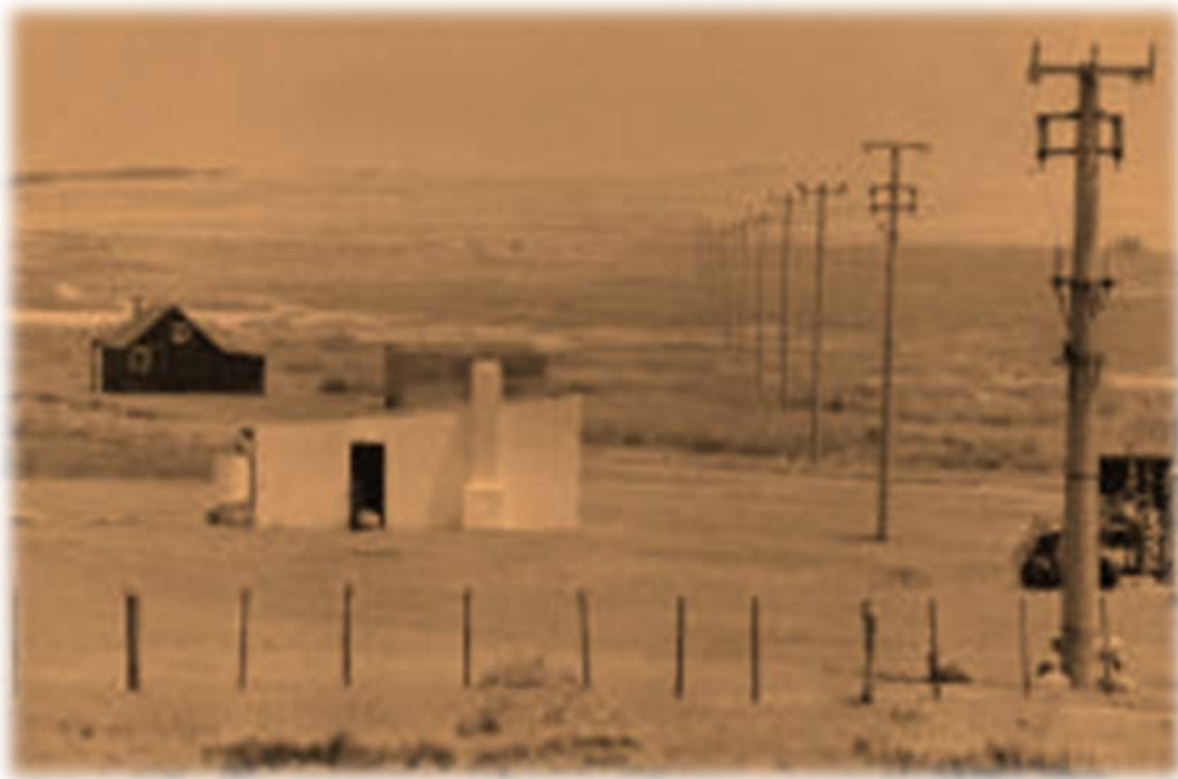
Fig. 91. Tendido de la red eléctrica. (1990)
